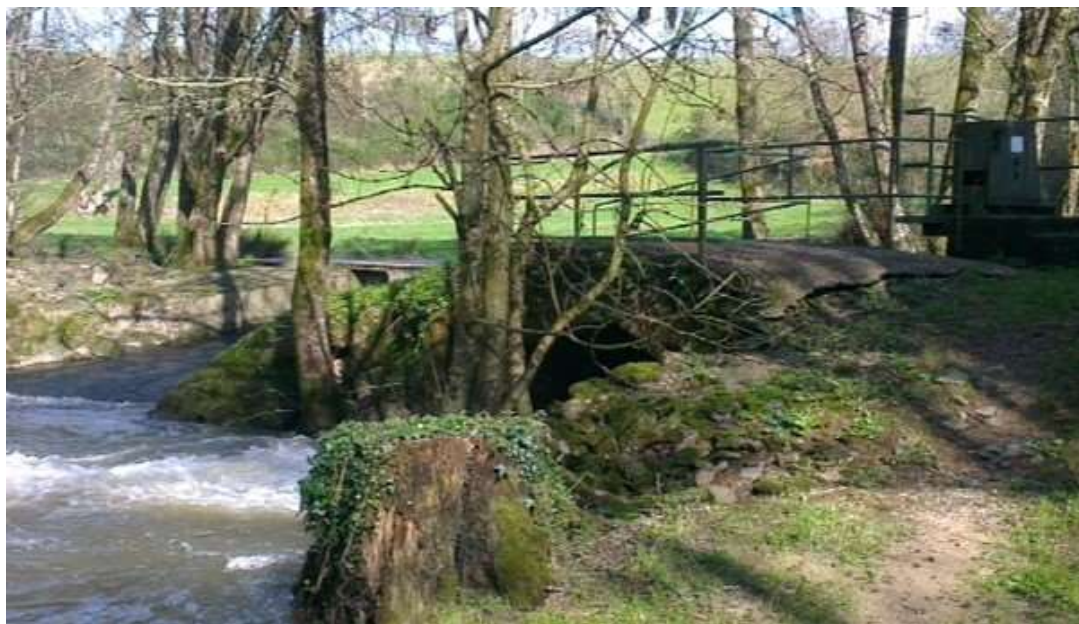
Chaussée de Bas Coûtet
