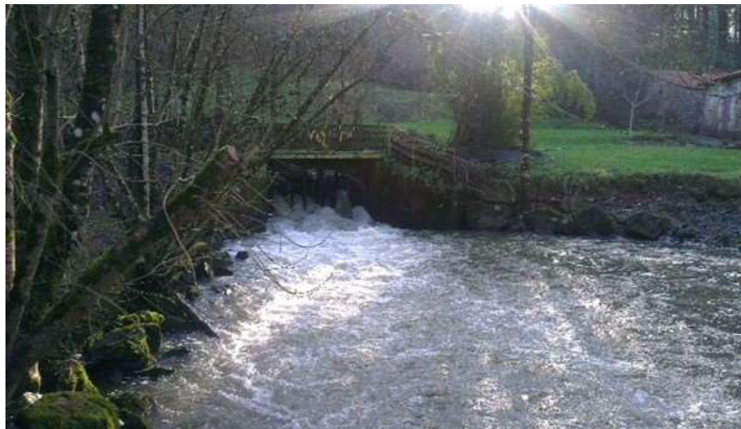
Chaussée de Boisneau
