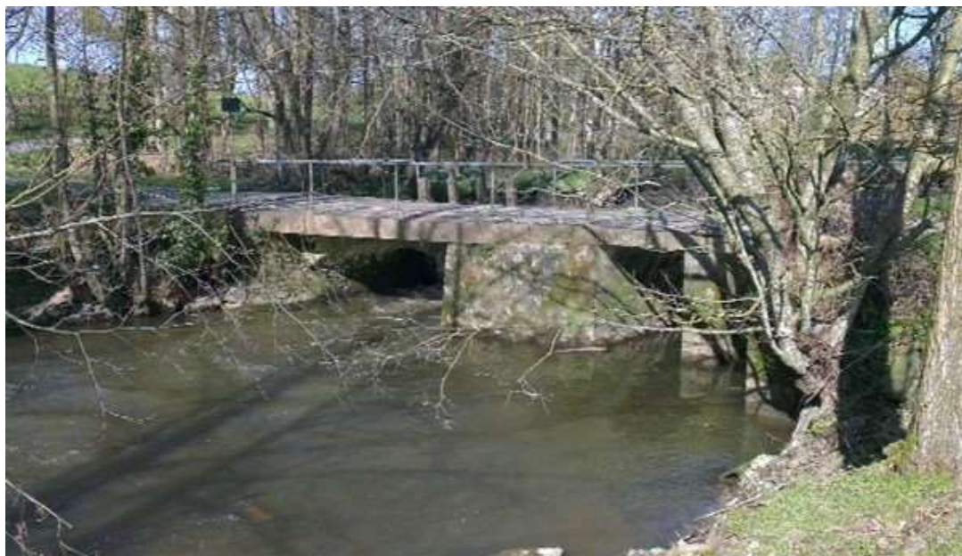
Chaussée de La Maurousse
