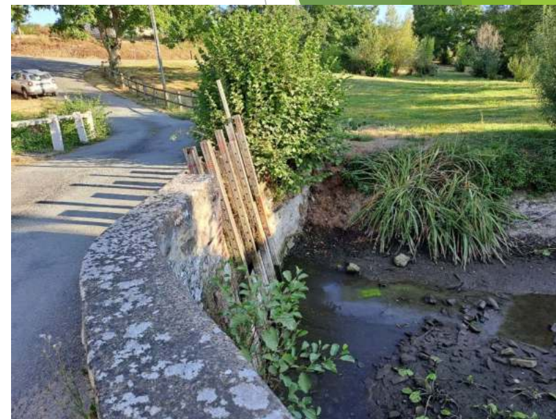
Restauration des pelles de l'ouvrage de Berton sur le Petit Lay – AAPPMA de Mouchamps
